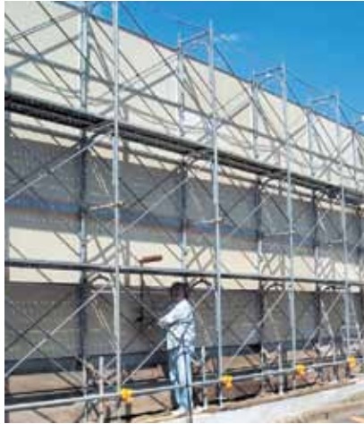
追加防音壁の設置施工
