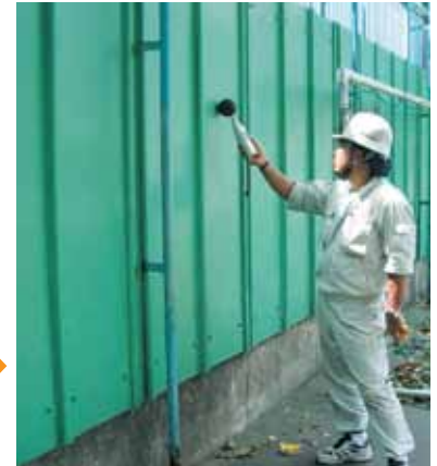
施工後の遮音性能確認計測
